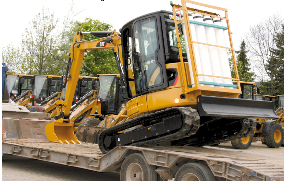
f-air-tec hat einen Cat Kompaktbagger 304CCR mit einer circa 470 Kilogramm schweren Atemdruckluftanlage ausgerüstet. Er arbeitete in hochkontaminierten Bereichen am Frankfurter Flughafen.
