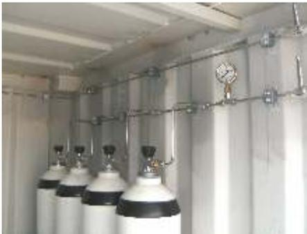
An einem manuell zu bedienenden Füllpanel befindet sich der Füllschlauch zum Überströmen auf die Fahrzeuge.
